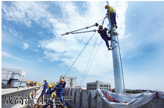
连日来，高温热浪袭击，上海轨交5号线延伸段建设工地格外火热，全线铺轨已经完成总量80%，计划9月轨通，10月电通，11月列车上线调试。图为工人在酷暑下安装高架电缆设施。
