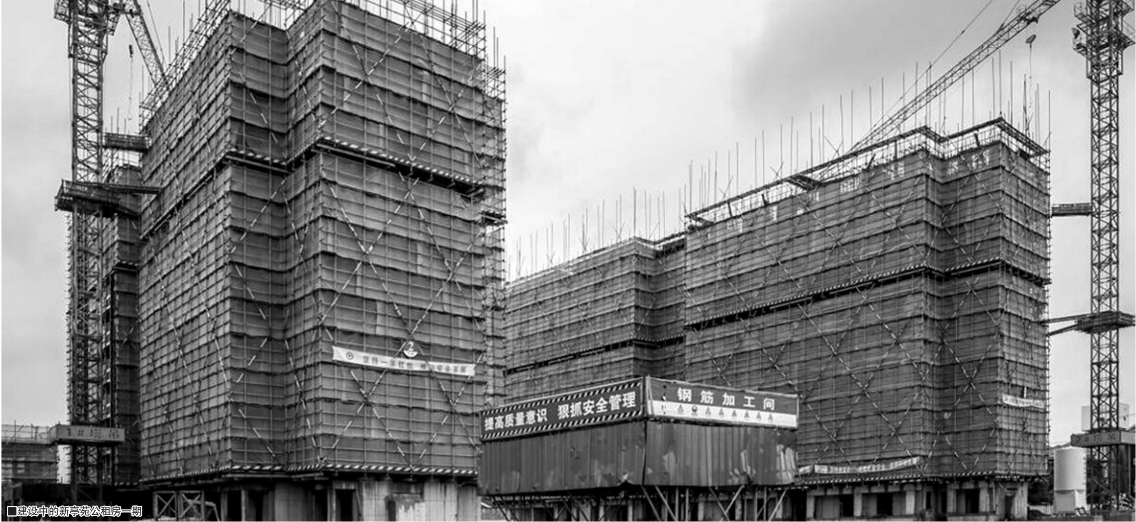
■建设中的新亭苑公租房一期
