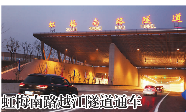
作为奉贤连接市区的又一重要越江通道,虹梅南路至金海路越江隧道于日前通车。据介绍,虹梅南路隧道是目前黄浦江底最长、也是当前国内最深(59 米)的城市越江隧道。它的通车,缓解了 S4 高速公路、莘庄立交及沪闵高架的交通压力。
