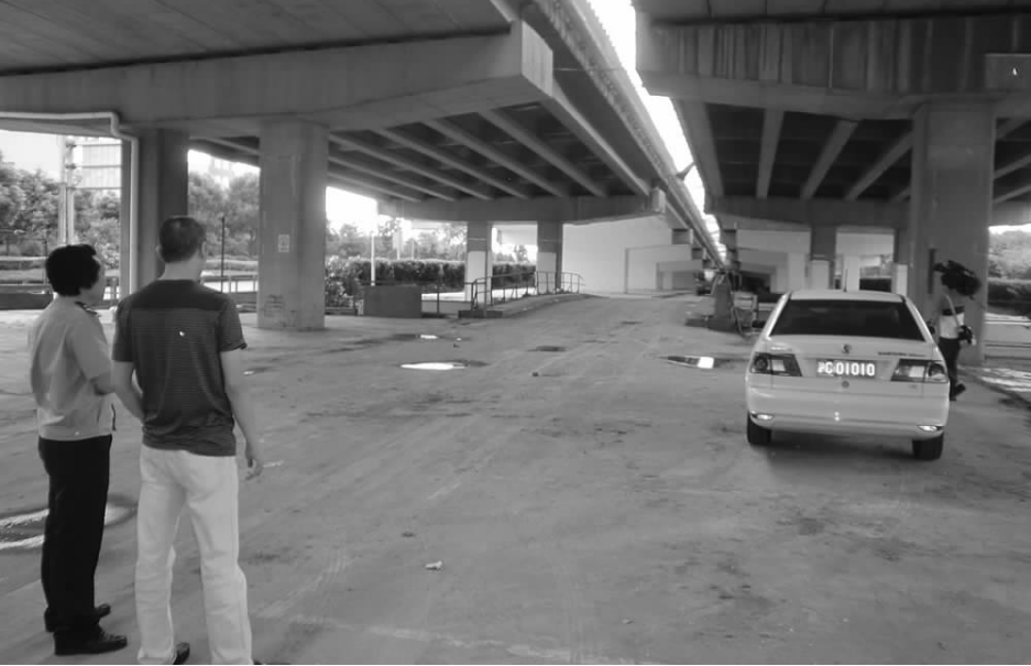
■位于沪青平公路华徐公路交界处、G15 高速下匝道桥洞内的 1400 平米违章搭建已全部拆除完毕，困扰该处多年的安全和环境隐患得以彻底消除。
