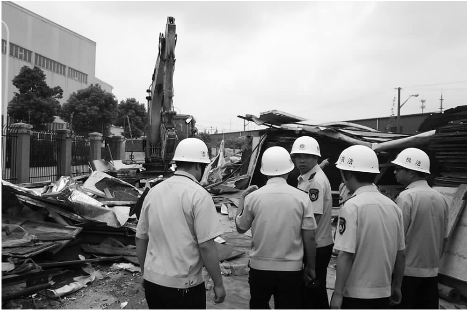
■图为曹路镇正在拆除光明村东靖路违法建筑。
