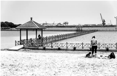
■图为新修的泳池栈道。
