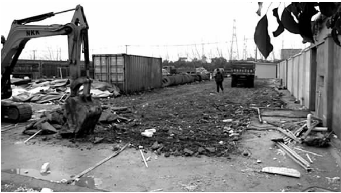
■图为泥城镇临港物流园区违法停车场的整治现场。
