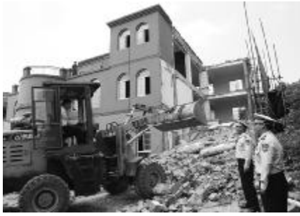
■图为拆违现场。
